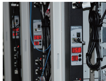
PDU全体とアウトレットごとの電圧、電流がLED表示される
